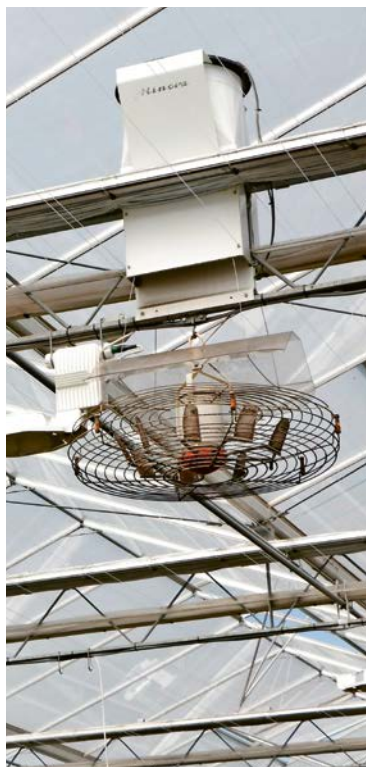
Het VentilationJet Systeem werkt met twee verticale ventilatoren. De bovenste zuigt buitenlucht door het gesloten scherm naar beneden, waar deze op een verdeelplaat valt. De onderste ventilator verspreidt de lucht.
