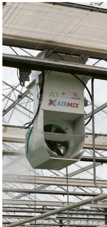
De Airmix is een van de drie systemen om lucht van boven een gesloten scherm in de kas te blazen. In het scherm zit een speciale opening om dit mogelijk te maken. De Airmix verspreidt die aangezogen lucht horizontaal.
