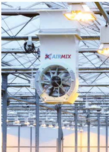
Airmix: gaat uit van ventilatoren voor horizontale circulatie en aanzuiging droge lucht.
