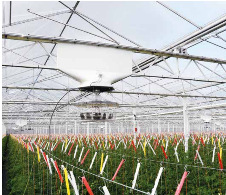
Bij een gesloten scherm trekt de bovenste ventilator via de koker droge lucht naar beneden, door het doek heen. De onderste ventilator zorgt voor menging en verspreiding.
